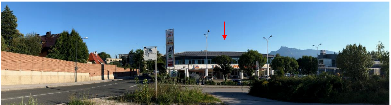
Abb 3: Bestandsgebäude aus nördlicher Blickrichtung.
