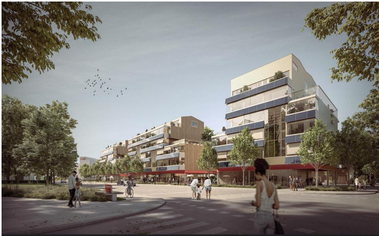
Abb. 3: Blick von Süd-West – Alpenstraße (Quelle: planendes Architekturbüro)
