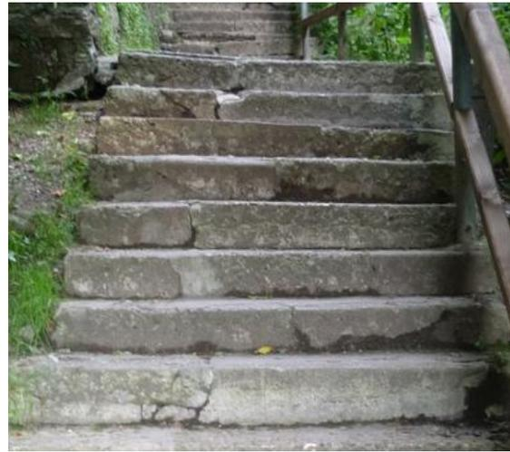
Abb. 2: Stiege mit brüchigen Betonergänzungen
