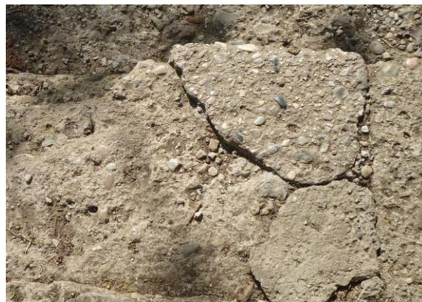
Abb. 3, 4 und 5: Betonplomben bzw. teilweise weggebrochene Betonplomben
